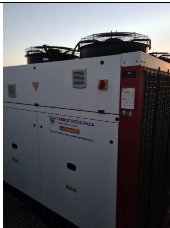
Groupes aéroréfrigérants se trouvant en toiture technique et qui s'arrêtent en même temps que la production de froid
