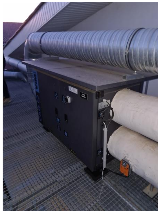
Centrale de traitement d'air
